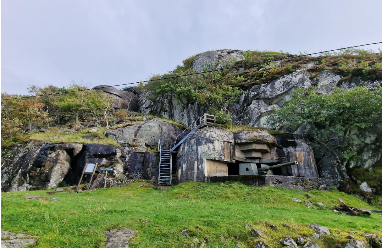
Figur 19. Varnes Fort -kommandobunker og 105 mm overbygd kanon (i kasematt) ligger på Hesvika-eiendommen.
