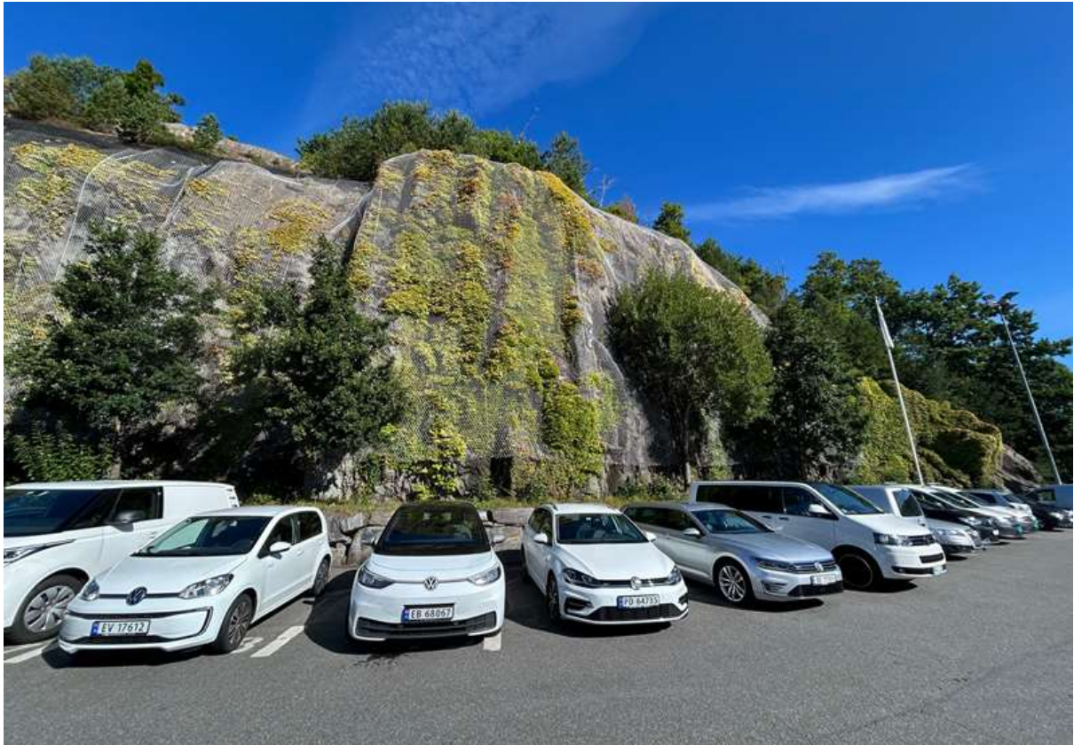
Figur 43: Eksempel på høy skjæring med beplantning foran (Gromstad)
