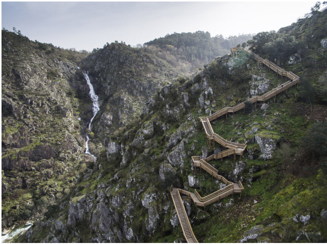
Paiva walkway i Portugal er ein god referanse på korleis den djupe dalen langs Otra kan gjerast tilgjengeleg på ein måte som inviterer til bruk.
