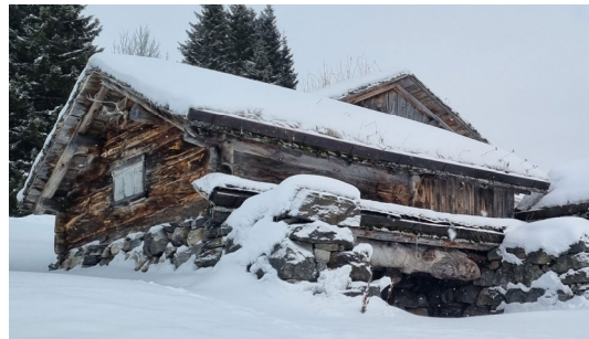
Bruk av terrengmurar er vanleg for å tilpasse bygga til det bratte terrenget i Bykle.
