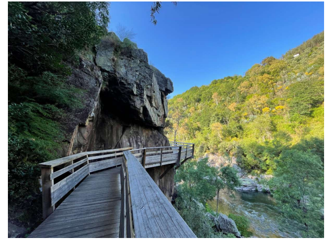
Ein bordgang kan gå rundt Sarvsnetten og binde sentrum saman med Otra på ein spennande måte. Bordgangen kan festast på den bratte fjellsida, slik som vist her i Paiva.
