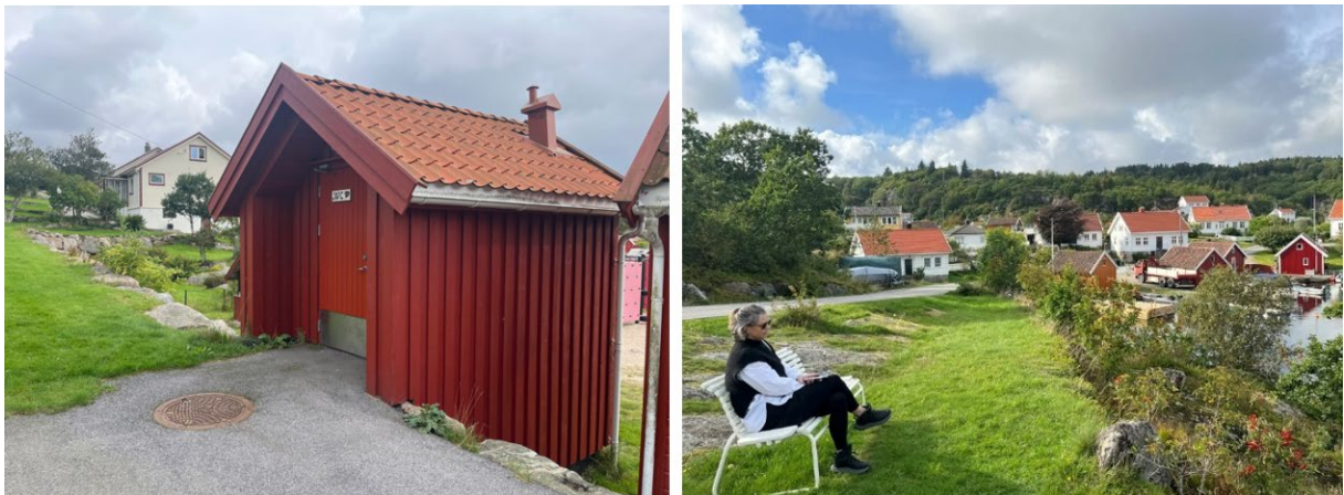
Figur 80: Fellesarealer på Nedre Farestad med pumpehus / toalett til venstre og slette med benk til høyre.
