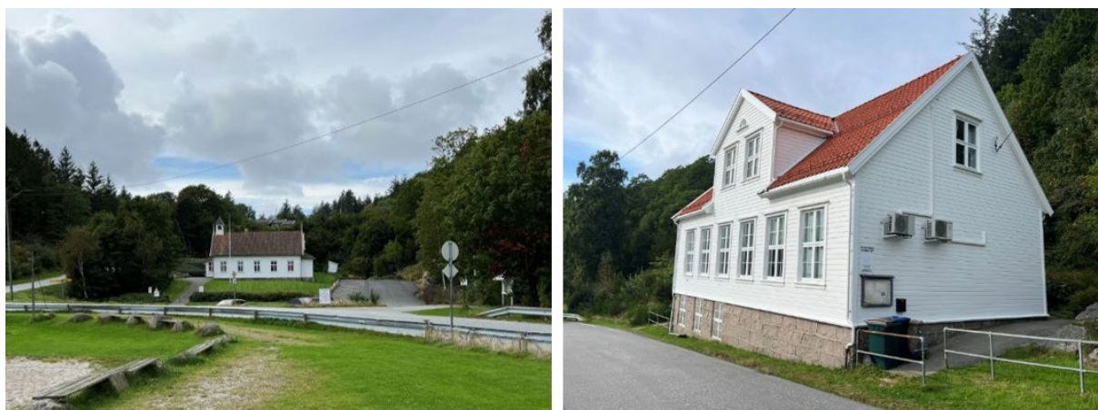
Figur 78: Kapellet til venstre og skolehuset / grendehuset til høyre, begge på Nedre Farestad.
