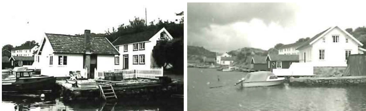
Figur 33: Våningshus fra 1890 og sjøbod fra 1898, begge på Rossnes. Kilde: SEFRAK.
