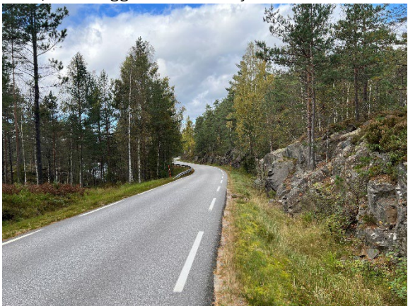
Figur 11 Bilde fra befaring
