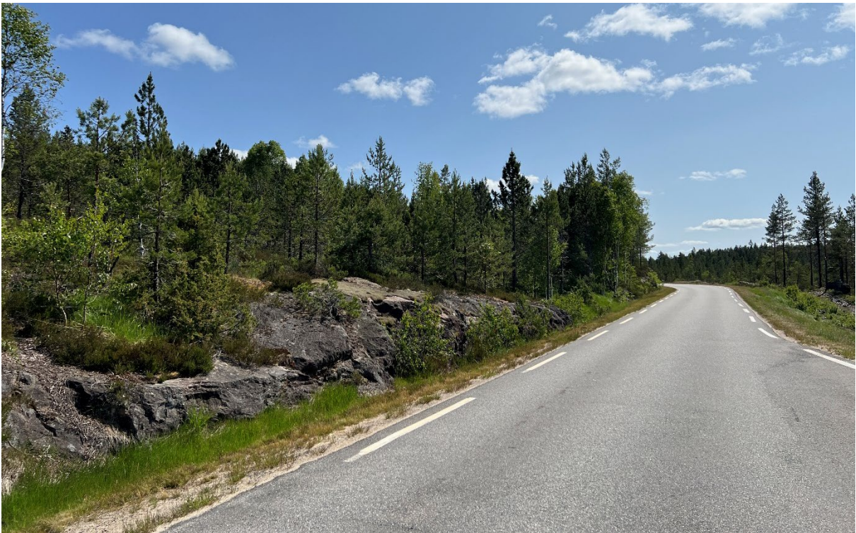
Figur 19 Bilde fra befaring, sett mot sør
