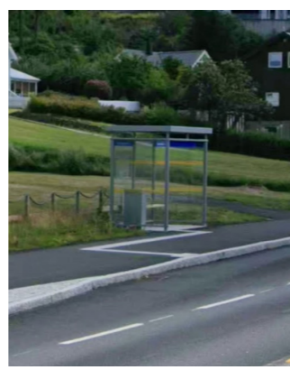
I forbindelse med oppgraderingen av Rv.41 ved Hamresanden ble holdeplassene i Grovika og ved Hamresanden syd opprustet med nye lehus og nytt repos.
