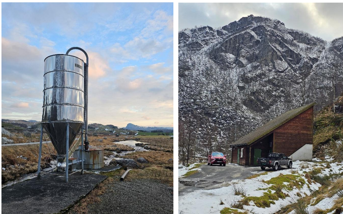
Figur 5 Bildene viser variasjonen mellom forskjellige kalkdoseringer i samme kommune (Bjerkreim). Til høyre: Dosering for Ognaelva (Eikeland) med kun mekanisk styring (eldre Lada-motor) og 9 tonn kapasitet. Til venstre: Anlegg for Bjerkreimselva i Bjordal, bygd i 2013. Digitalt styrt med eget pumperom, «silorom» og kontrollrom, 120 tonn kapasitet. Foto: A.V. Jenssen, januar 2026
