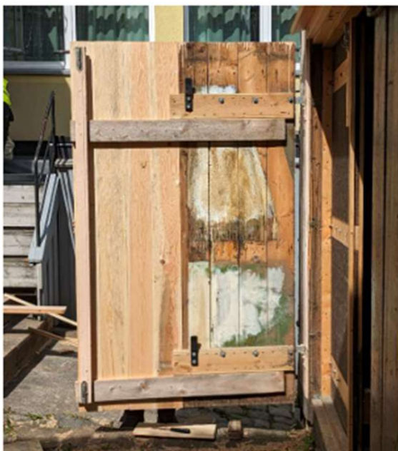
Foto før venstre dørblad fores ut. Under: Venstre dørblad foret ut. Dørbladet festes til karmen med slåer oppe og nede.
