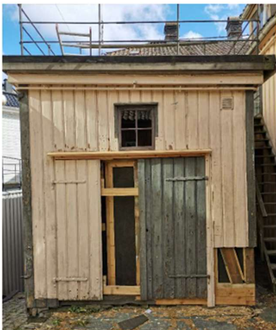
Foto før venstre dørblad fores ut. Under: Venstre dørblad foret ut. Dørbladet festes til karmen med slåer oppe og nede.
