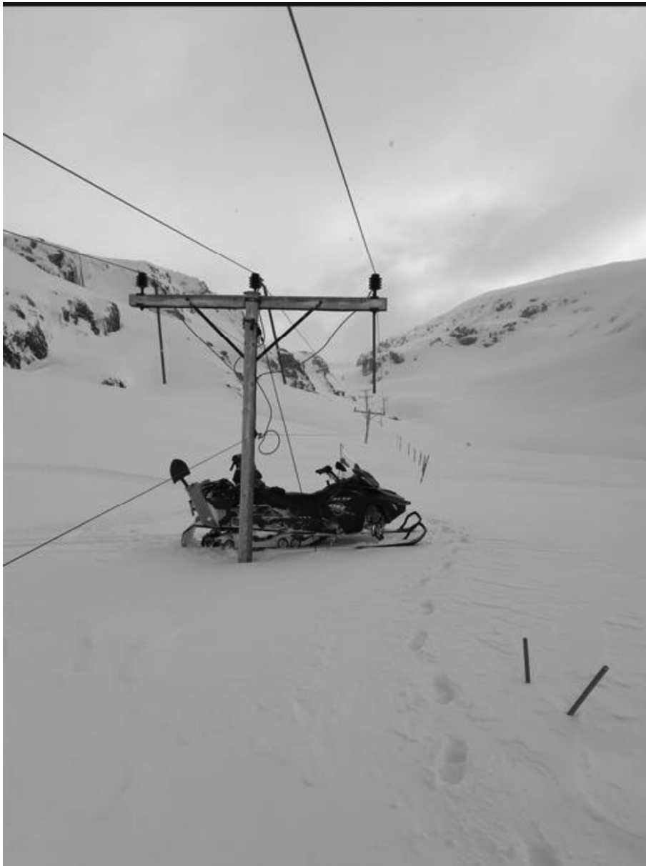
Foto over er levert av RSK, og viser tilsyn med 22 kV-ledning Blåbergdalen-Grubbedalen under forhold med mye snø
