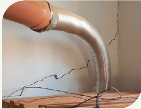
Eksempler på skader og sprekk i betongen
