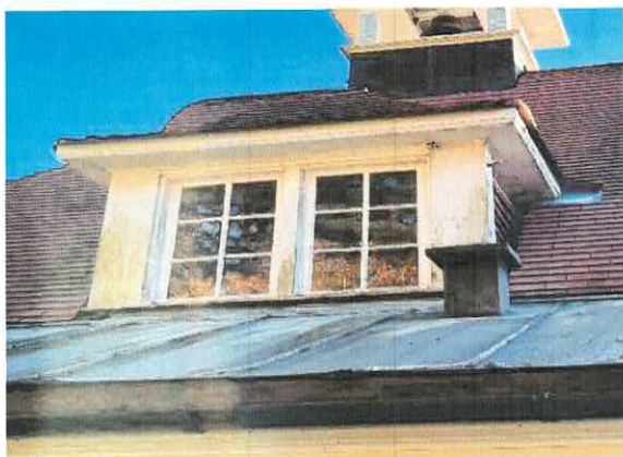
Båndtekking på Klokkehuset.
