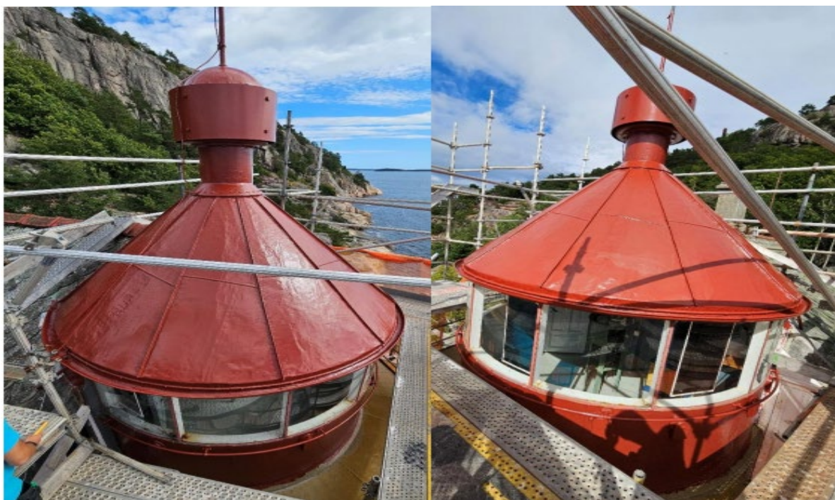
Øvre kobbertak og takrenne malt med full spec.
