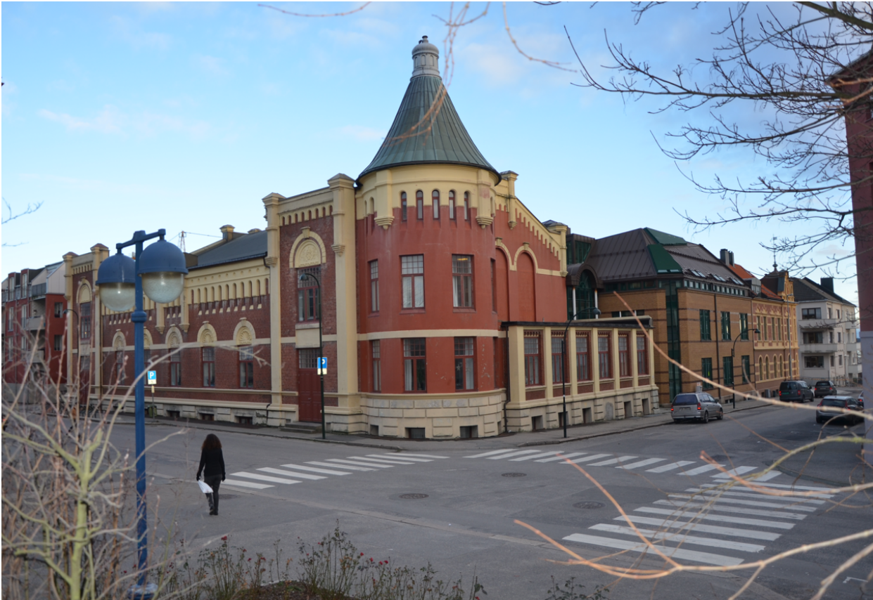
Bilde 2: Turnhallen fra før tårnet og grunnmuren ble malt.
