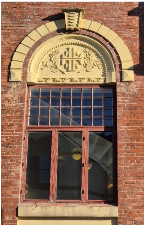
Bildet 3: Bildet viser vinduet øverst på høyre side av fasade mot Kongensgate. Over vinduet ses turnforeningens logo. Det har vært tilsvarende logo i feltet over vinduet på venstre side. Begge disse ses på bilde nr 4. I planforslaget vil disse feltene erstattes med vinduer (se illustrasjon på bilde nr.5).
