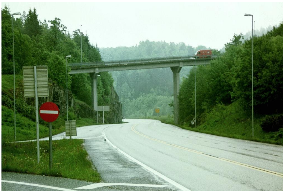
Bilde: Statens vegvesen, Rømyr bru
