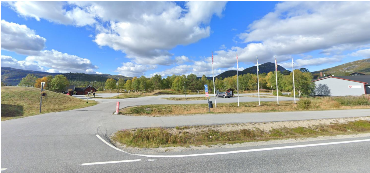
Figur 8 – Frå Rv9. p-plass med midlertidig bubilparkering, nedlagt reinseanlegg til høyre. (Google Maps).
