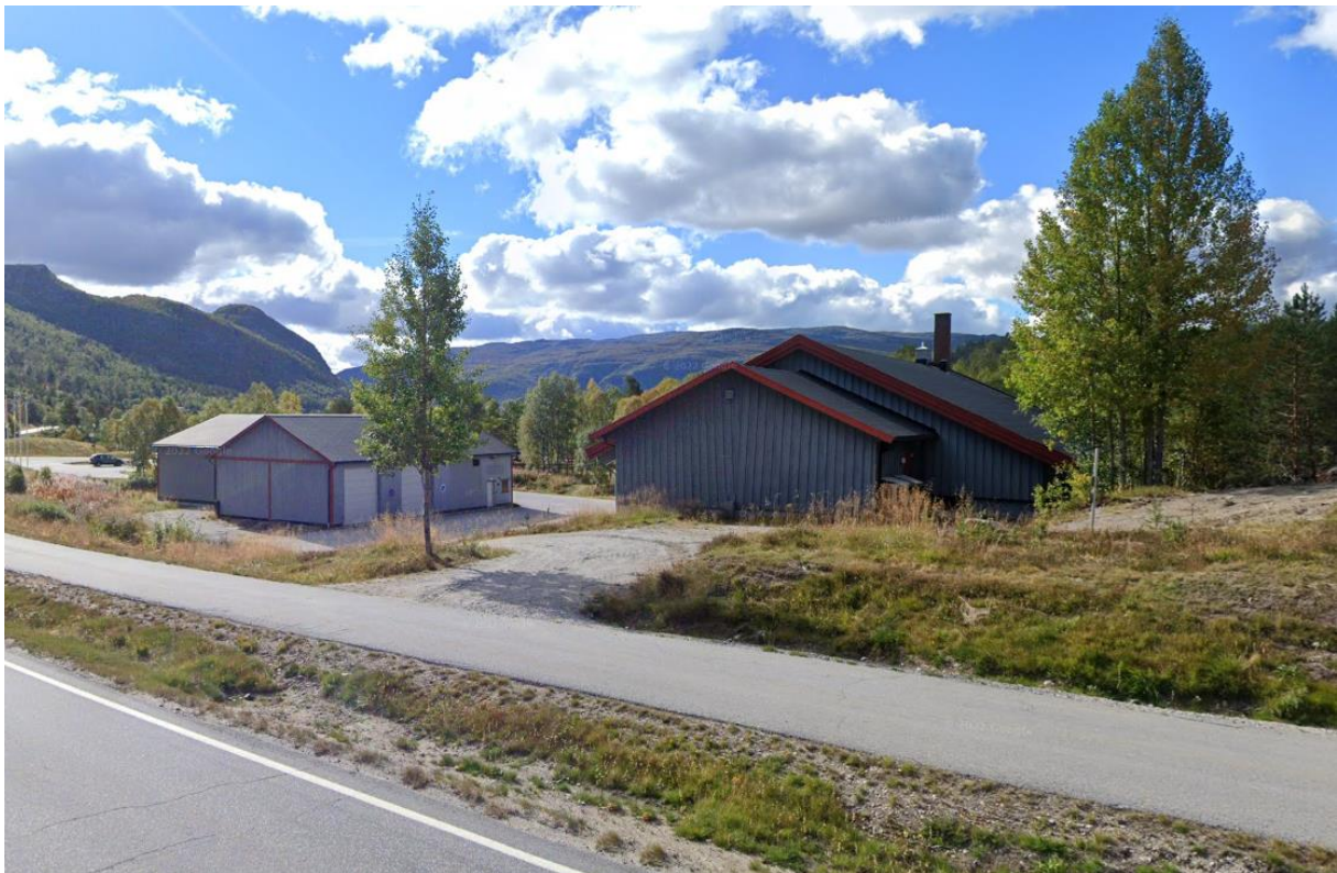
Figur 9 – Brannstasjonen nærmast, og det nedlagte reinseanlegget til venstre. (Google Maps).
