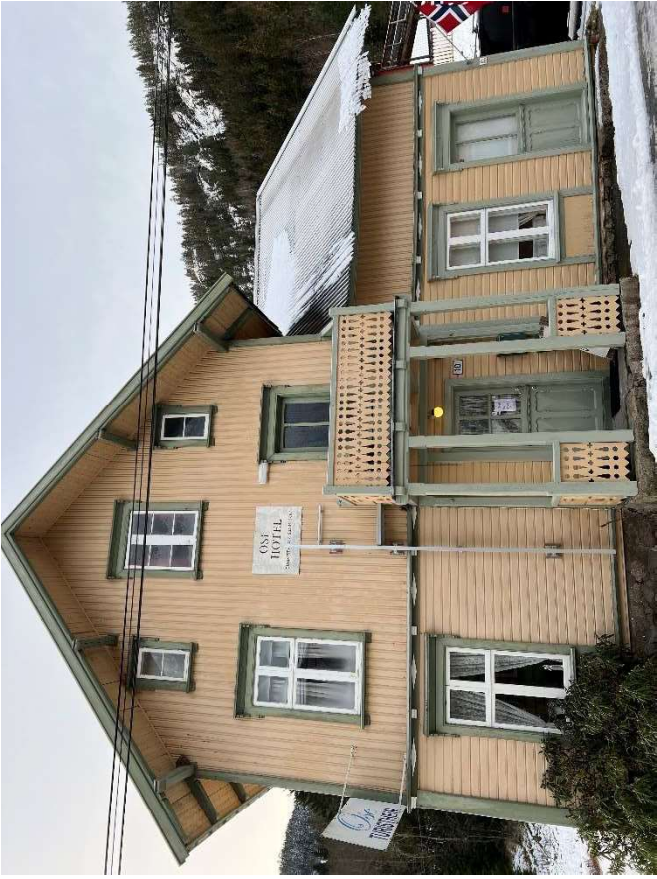
Fasade mot nord-aust
