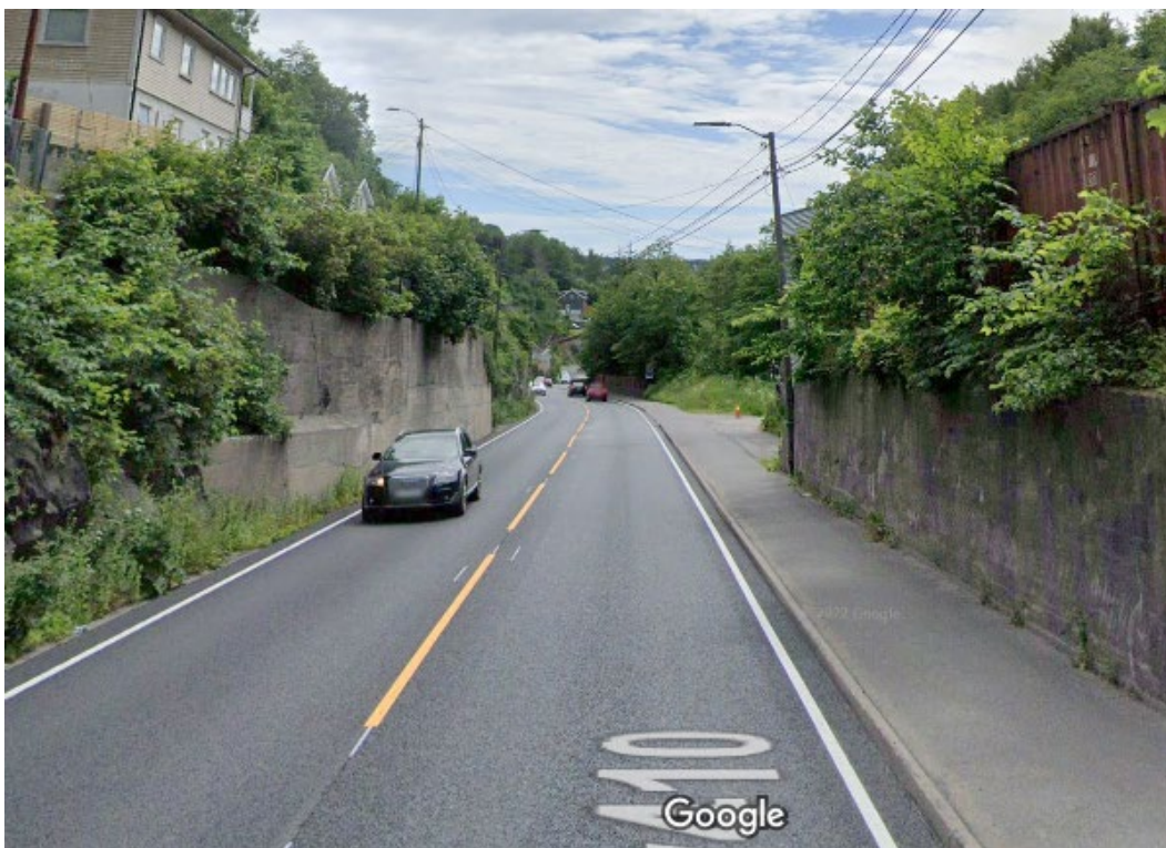
Figur 3. Bilde som viser fortau langs fv. 410 ned Barbudalen (Foto Google).
