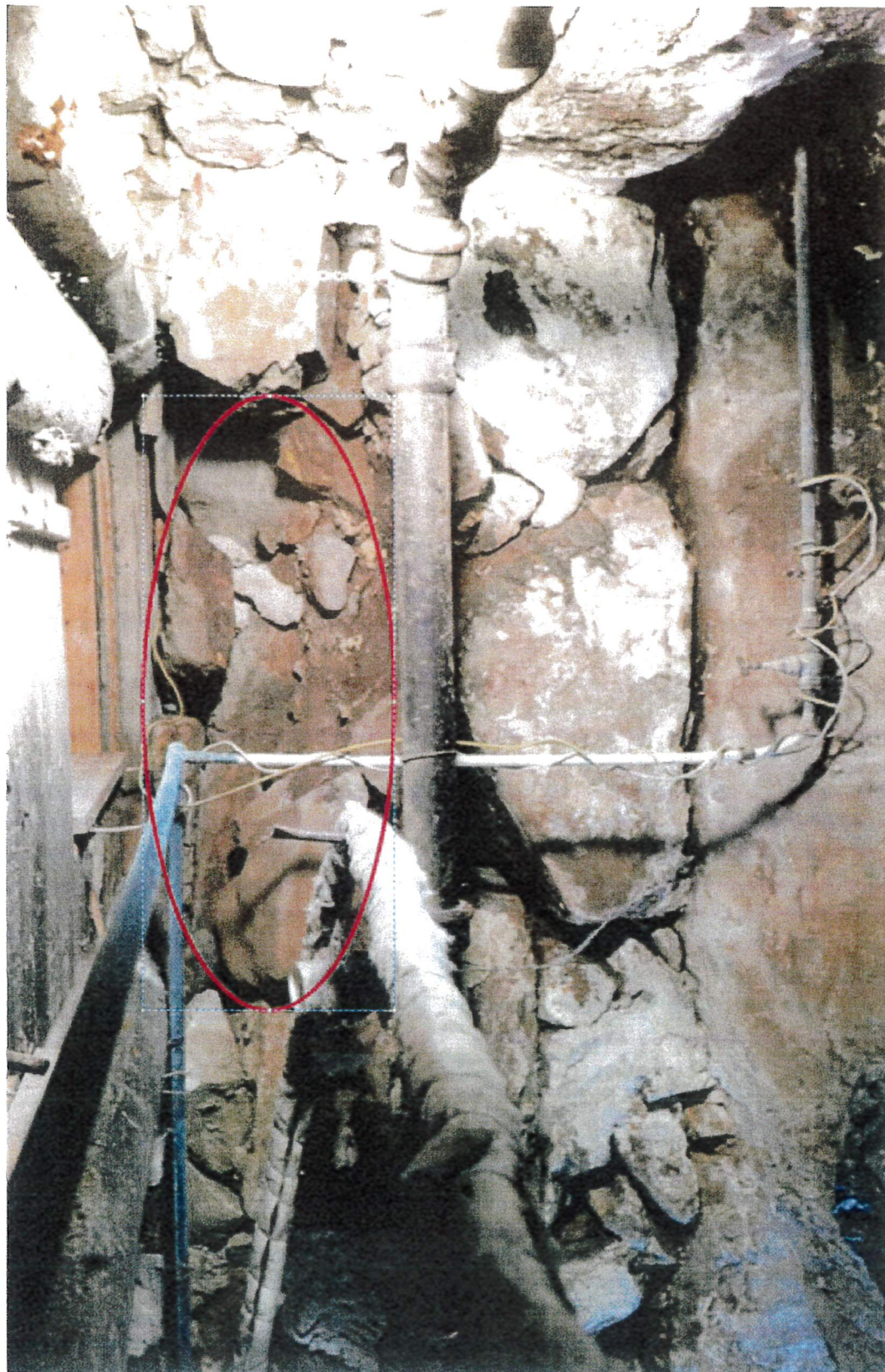
Bilde viser grunnmuren mot vest. Som man ser fremstår denne delen av grunnmuren mer som en varde, hvor steinene ligger løst og kan plukkes ned for hånden. Området som er merket med en rød ring viser det området hvor grunnmuren har kollapset og som omfatter et område på ett par meter. Som man ser er bunnsvillen godt synlig og både bunnsvillene og bærebjelkene i dette partiet henger i luften..
