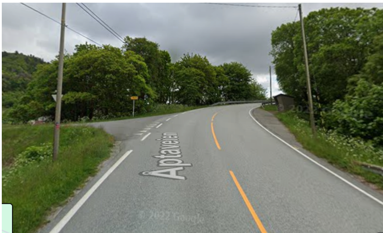
Figur 3 Kryss ved fylkesveien som ikke oppfyller krav til friskt og busstopp på vestsiden av fylkesveien. Bilde fra google.maps.no
