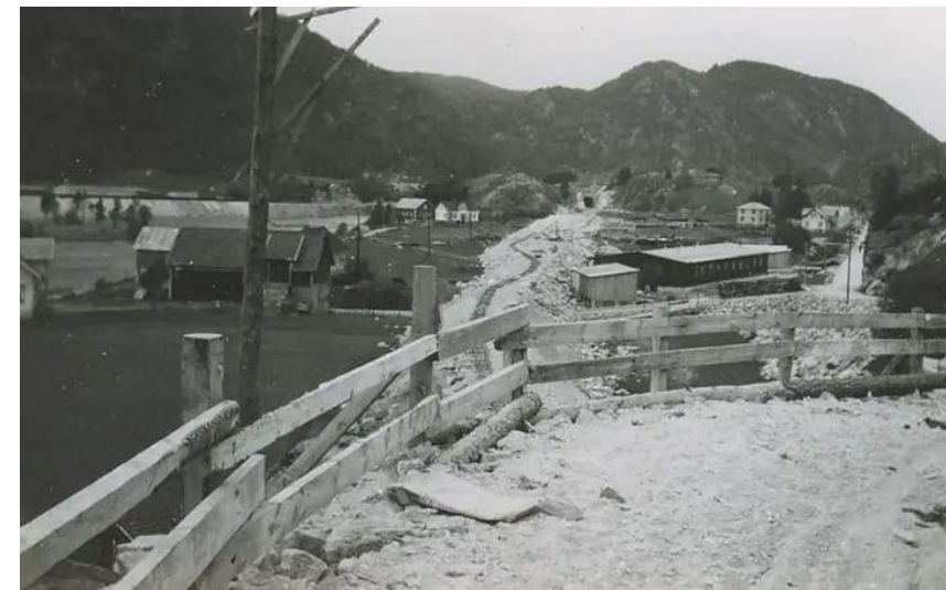
Foto fra Myra i 1941 - Jernbanelinja bygges
