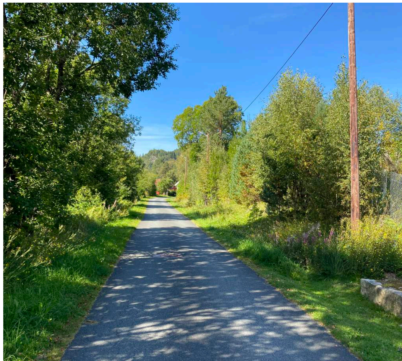
Foto fra registrering høsten 2023 som viser parti fra lokalvegen Refskarmonen, på elvesida av jernbanen
