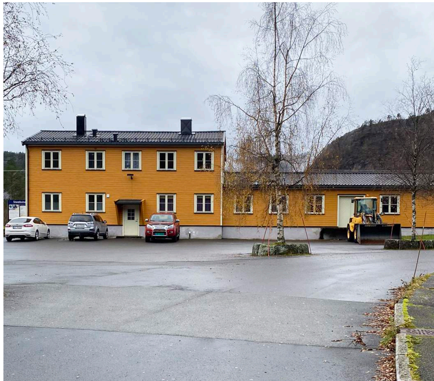
Foto fra registrering høsten 2023 som viser Storekvina stasjon
