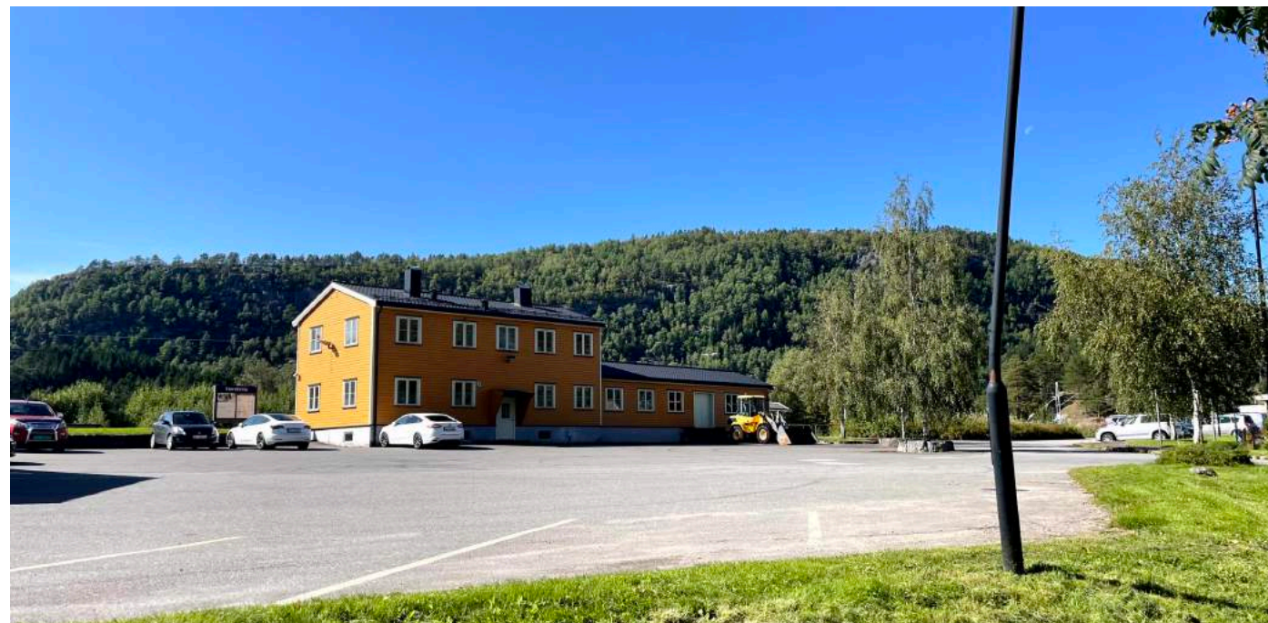
Foto fra registrering høsten 2023 som øverst viser Butikken og nederst parkeringsplassen mellom stasjonen og butikken (som vi her har kalt Stasjonsplassen)
