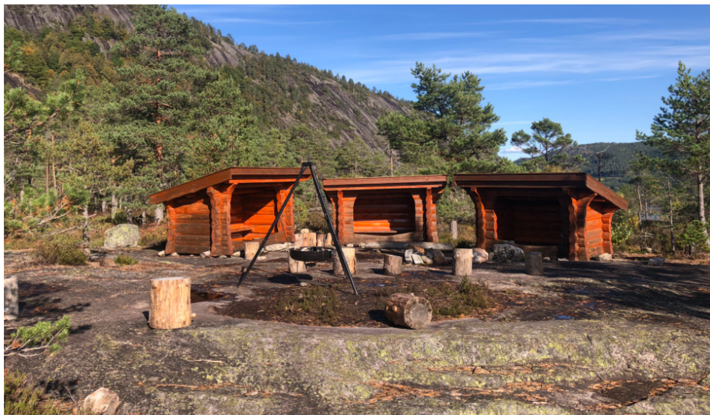
3 gapahuker står tett sammen på vei opp mot Trogfjell i Åmli.
