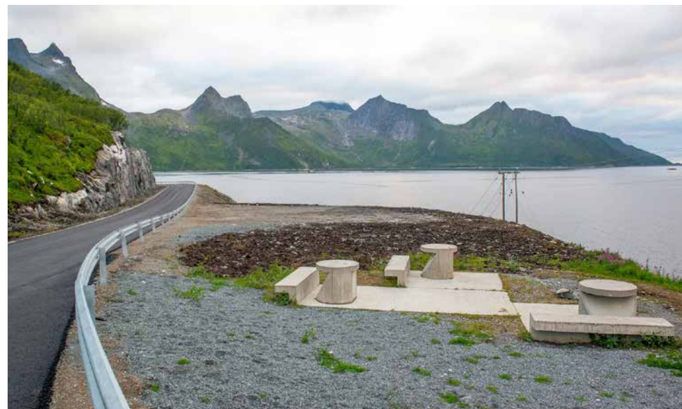
Enkelt opparbeidet utsiktspunkt i Mefjorden, Senja
