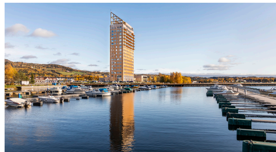
Mjøstårnet i Brummundal: verdens nest høyeste trebygning. 18. etasjer og 85,4 m høyt. Inneholder hotell, leiligheter, kontor, restaurant, og svømmeanlegg.
