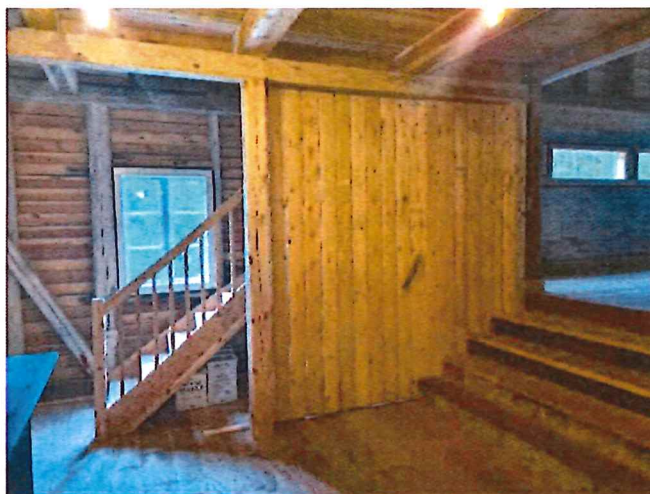
Sjalusiveggen går på skinner, og når den er lukkes, så slipper lyset fra det eneste vinduet inn i hele rommet (skålen).
