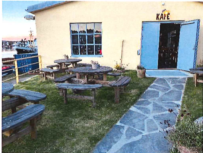
Gamlemessa har fått nytt inngangsparti og terrasse med rampe for rullestolbrukere fra parkeringsplass til dør
