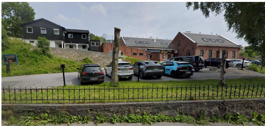
Figur 5-2 Administrasjonsbygg og fengselsanlegg (Kilde: Google Maps)
