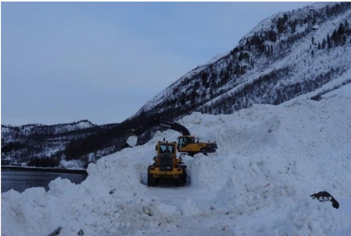
Snøskred stenger vei. Foto: Statens vegvesen
