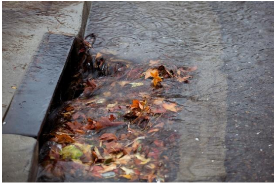
Tett avløp ved flom. Foto: iStock
