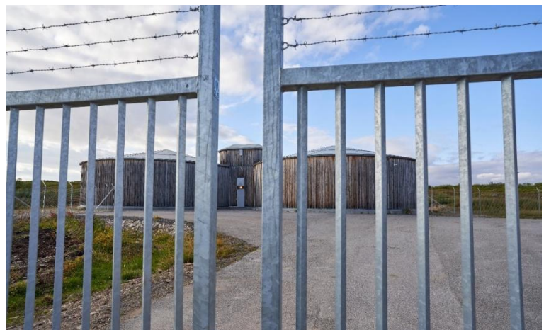
Vannverk med fysisk sikring, Foto: Ruben Mathisen
