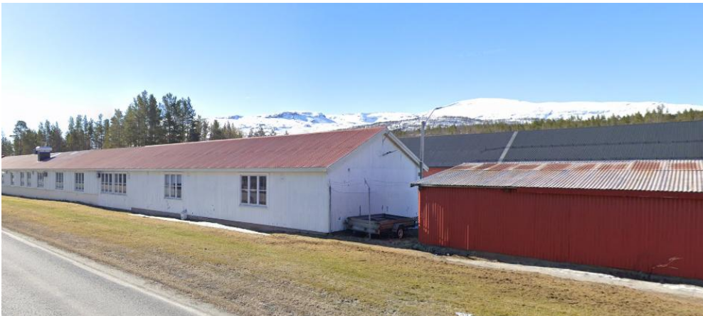
Figur 12: Bebyggelse mot Altevannsveien sørvest i planområdet (Kilde: Google Street view)
