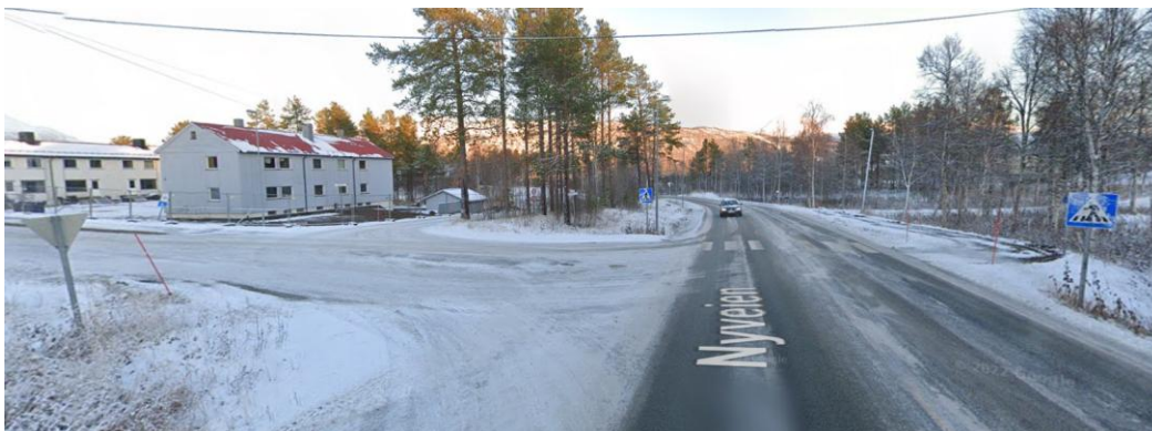
Figur 34: Overgangsfelt ved Toftaker. (Kilde: Google street view)
