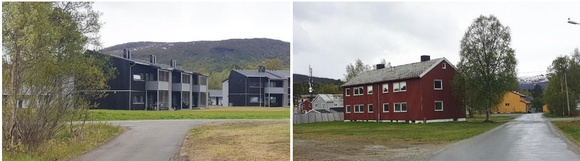
Figurer 8: Rekkehus og tomannsbolig like ved Setermoen sentrum. Boligene benyttes av ansatte i Forsvaret (Foto: 3RW arkitekter, befarig 2023)
