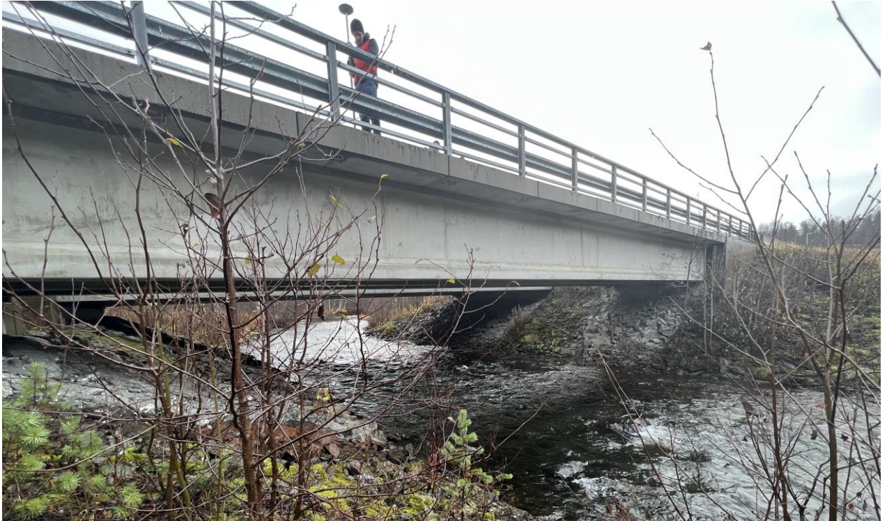
Figur 8: Bilde av brua ved Artillerileiren, sett fra nedstrøms side
