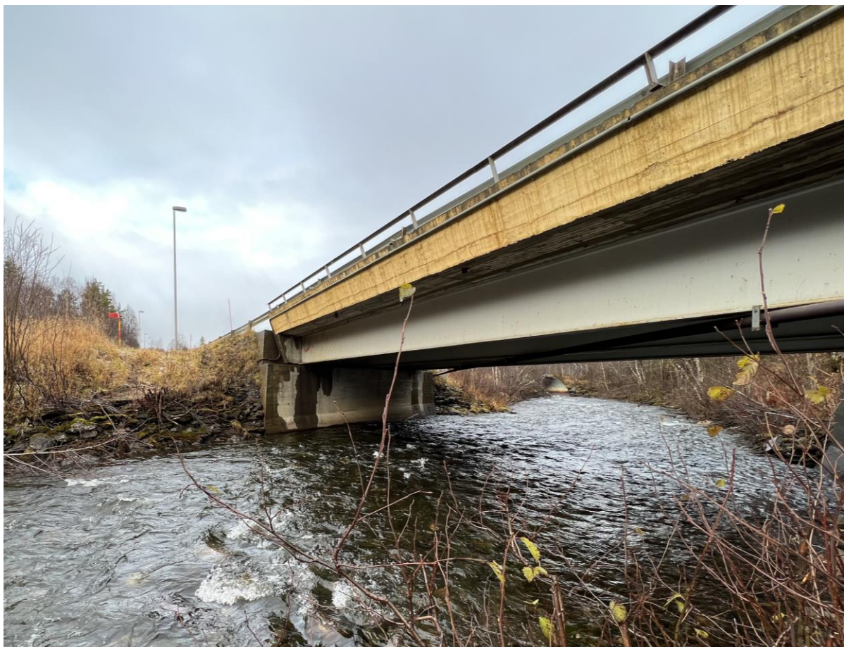
Figur 6: Bilde av bru Altevannsvæien, sett fra oppstrøms side. Skimter kulverten i enden av bildet.
