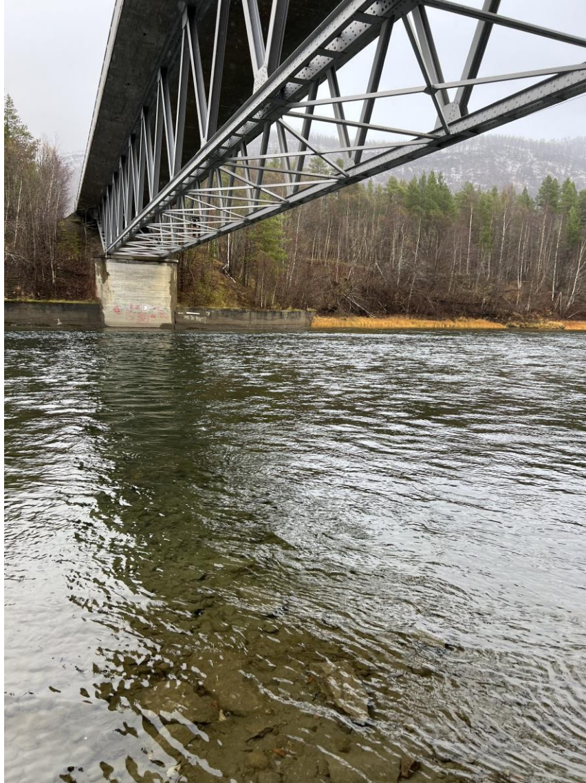
Figur 13: Bilde av brua ved Spongaveien, sett fra vestsiden av elven.
