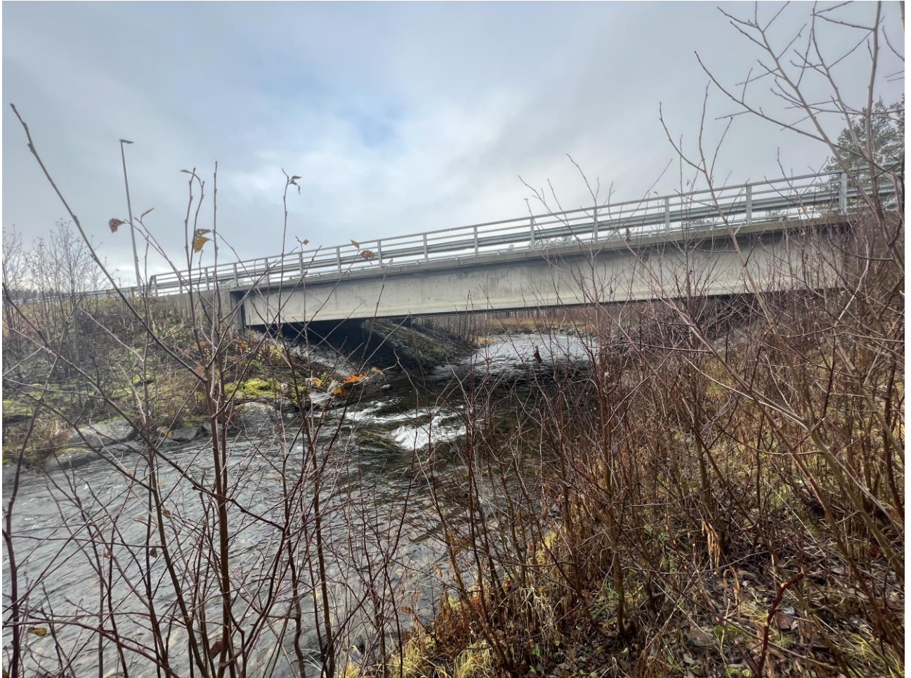
Figur 9: Bilde av brua ved Artillerileiren, sett fra oppstrøms side
