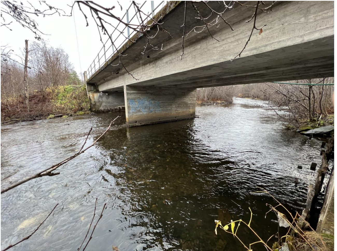
Figur 11: Bilde av brua ved Infanteriveien, sett fra nedstrøms side
