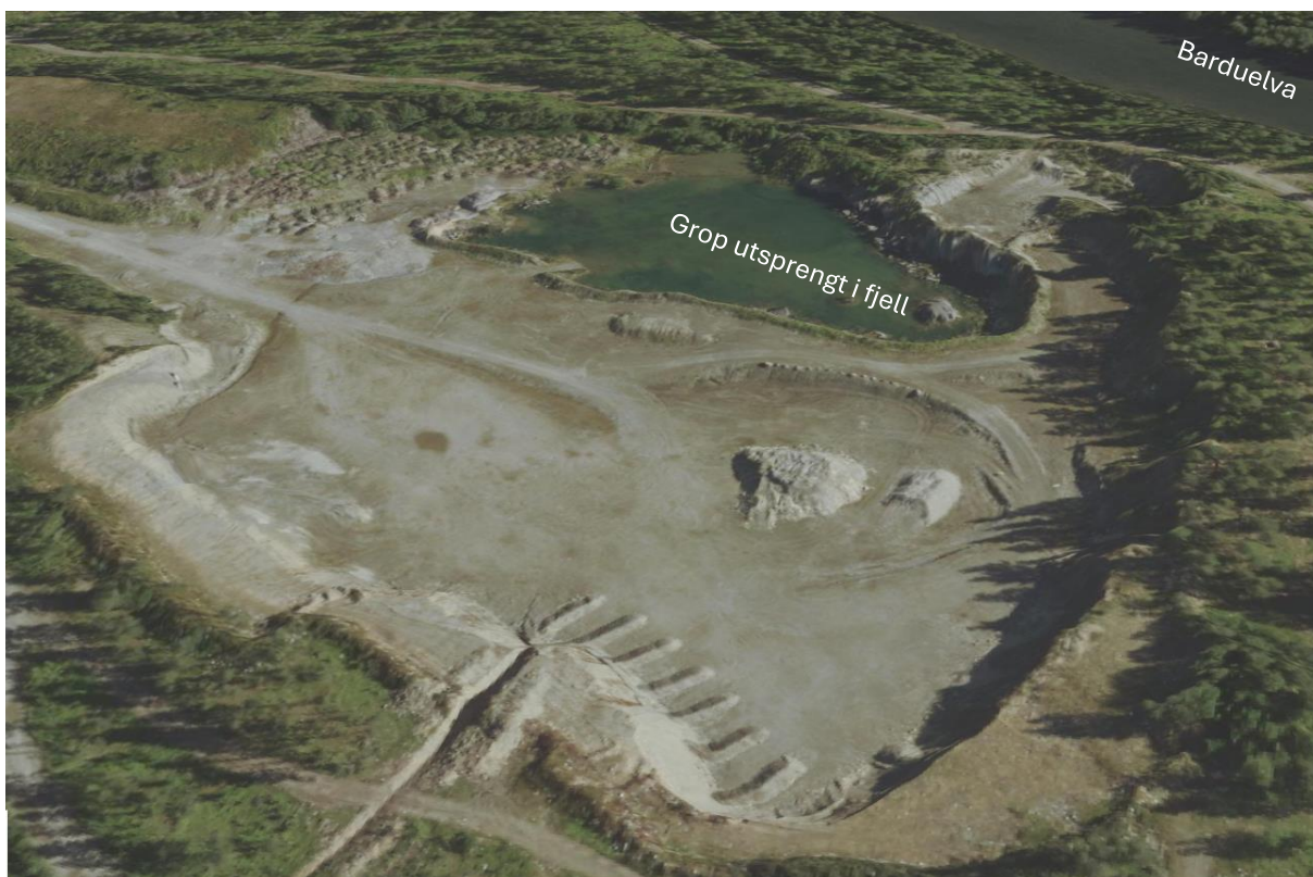
Figur 7-2: Mellomlager for rene masser. Det er ei grop i området som er sprengt ut i fjell, som er blitt fylt med overflatevann fra omkringliggende områder. Barduelva vises øverst til høyre i bildet. Kartkilde: www.3d.kommunekart.com .
