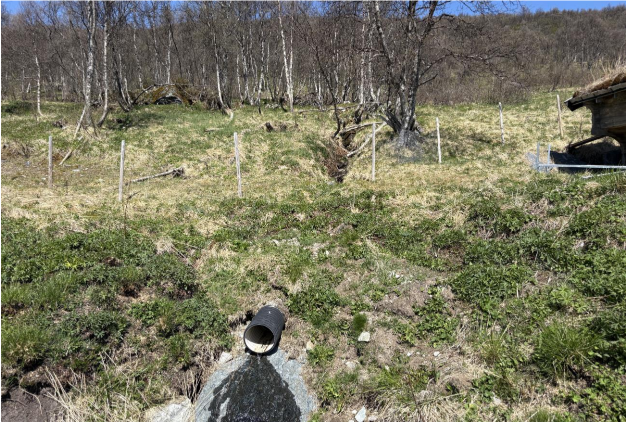
Bilde 1: Infopunkt 1 i Vedlegg 2 og 5. Bekk med lite vannføring. Ikke tegn til aktiv erosjon. Sett mot nord.
