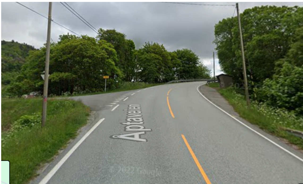
Figur 3 Kryss ved fylkesveien som ikke oppfyller krav til frisikt og busstopp på vestsiden av fylkesveien. Bilde fra google.maps.no
