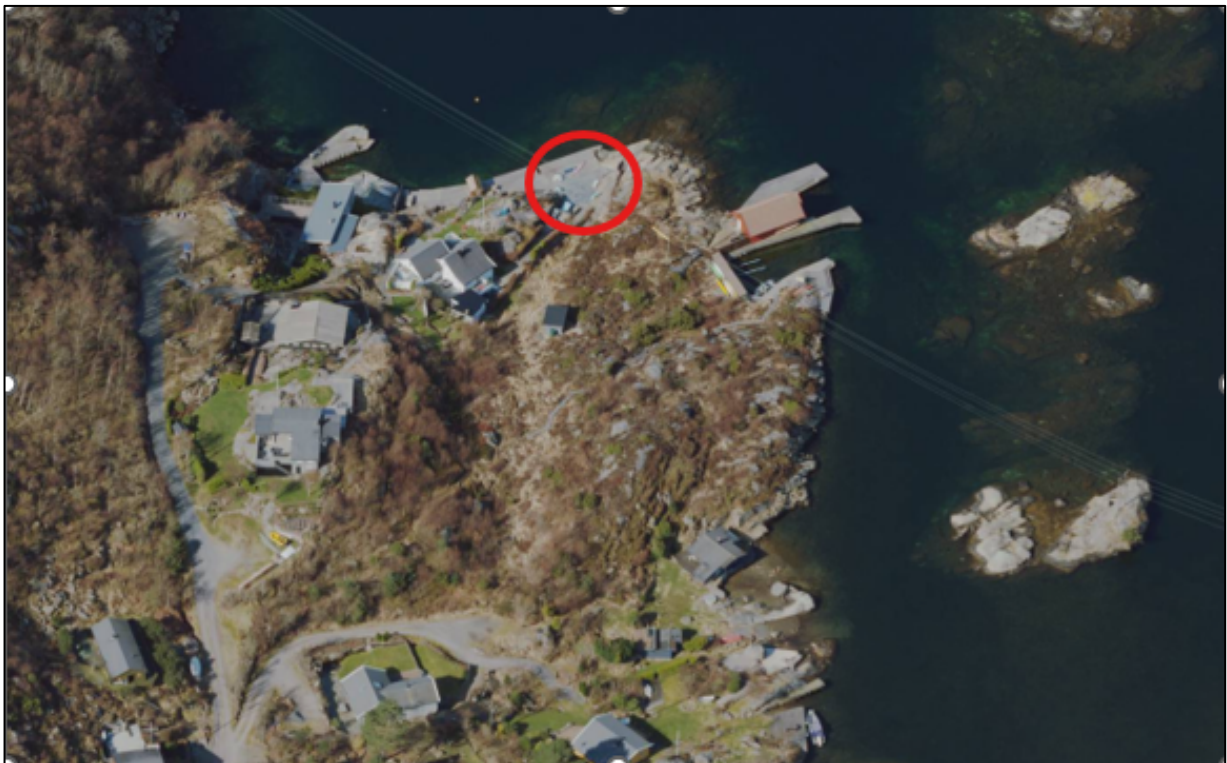
Brygge og skiferplattning markert med rød ring – sett fra øst mot vest
