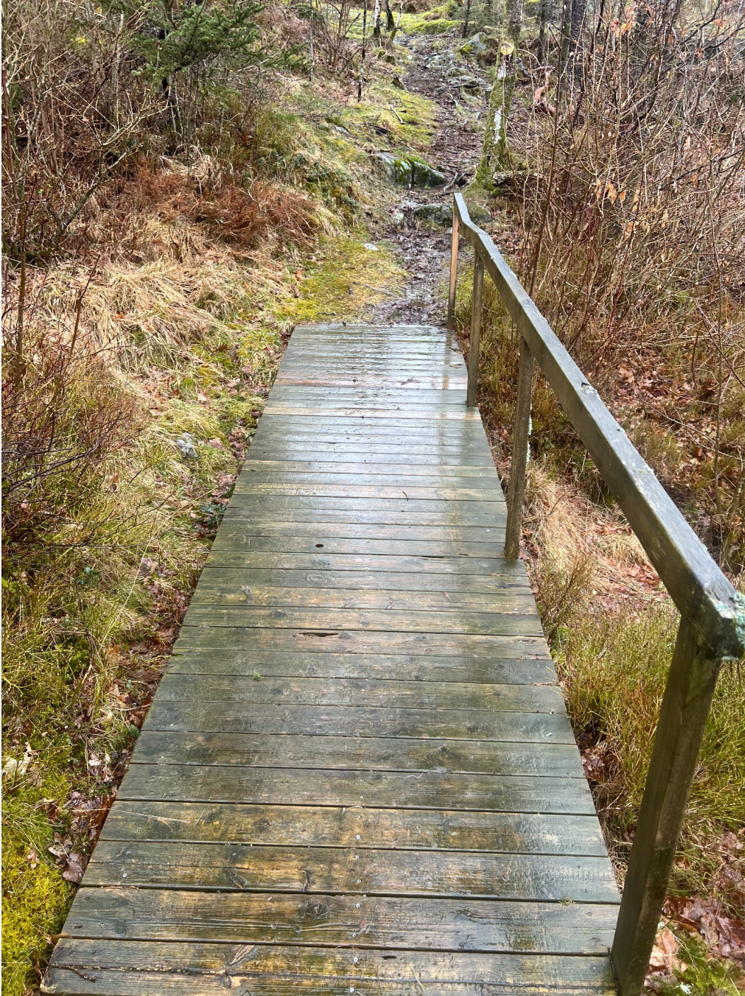
Vedlegg 2: Gangbro og smal sti – viser begrenset fremkommelighet.
