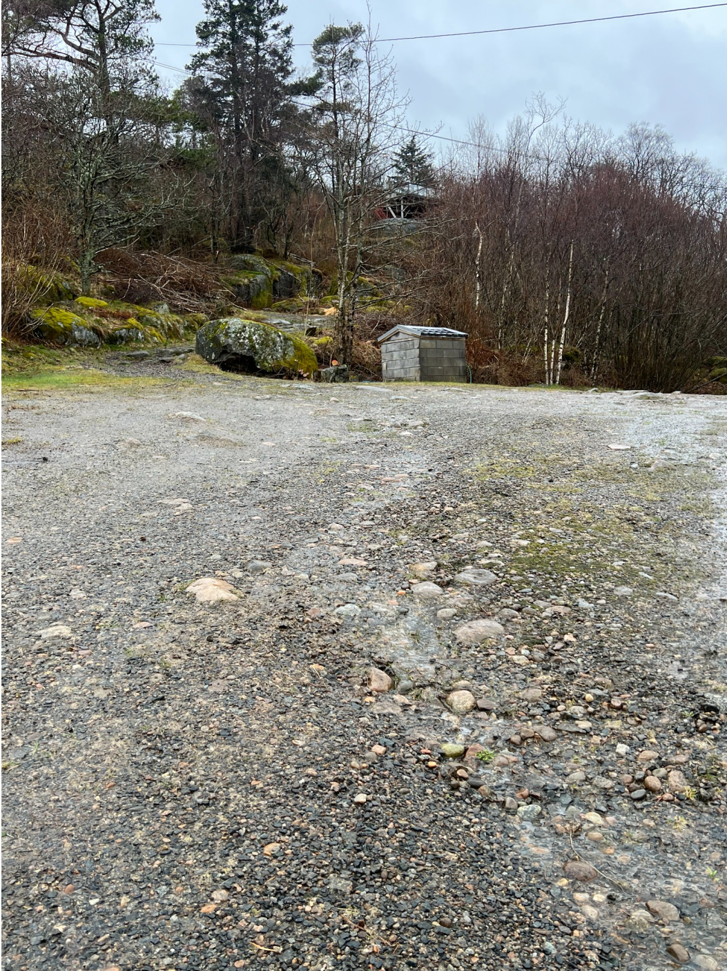
Vedlegg 5: Ujevn adkomst fra vei – vanskelig under dårlige forhold.
