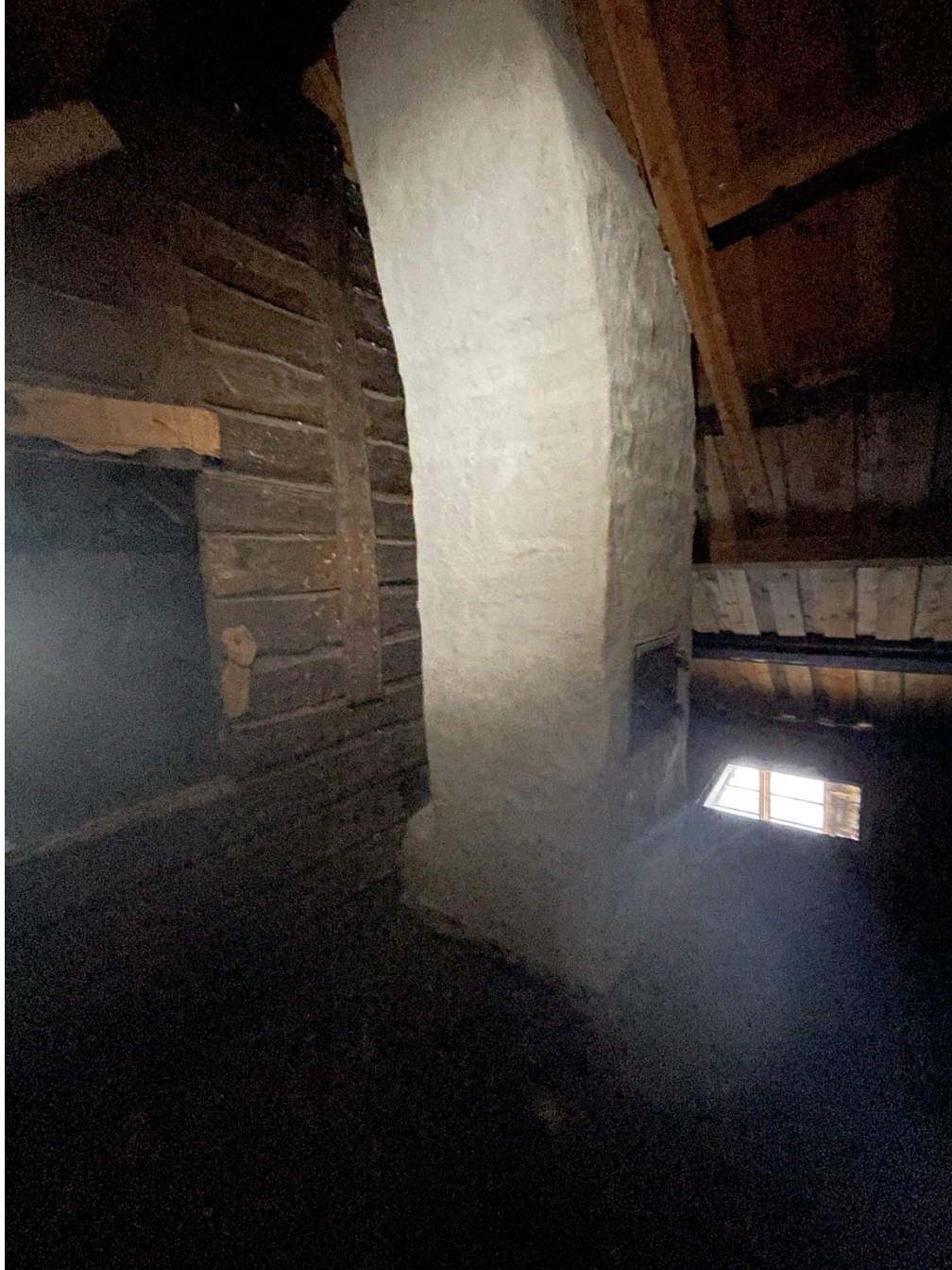
Etter stabilisering av ildsted og murverk.
