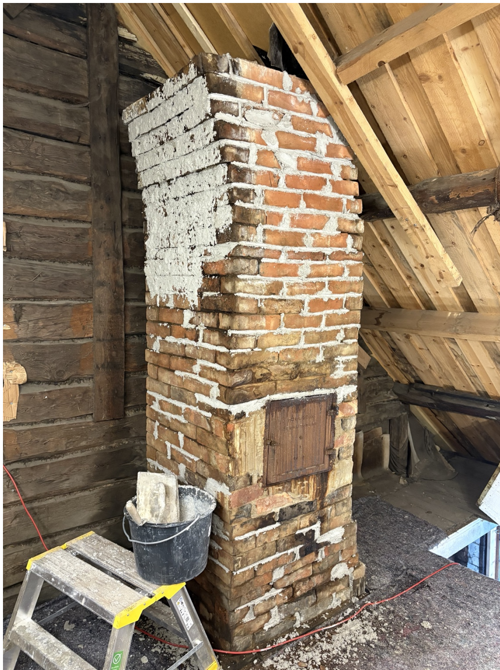
Detalj av brennkammer med sot- og varmeskader.
