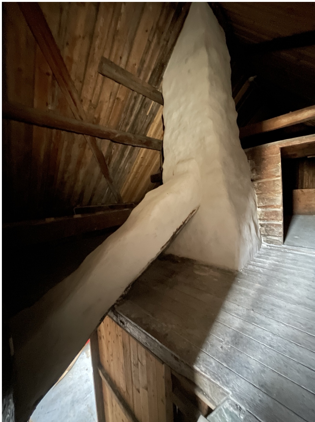
Etter stabilisering av bakvegg, pipe og brannmur.
