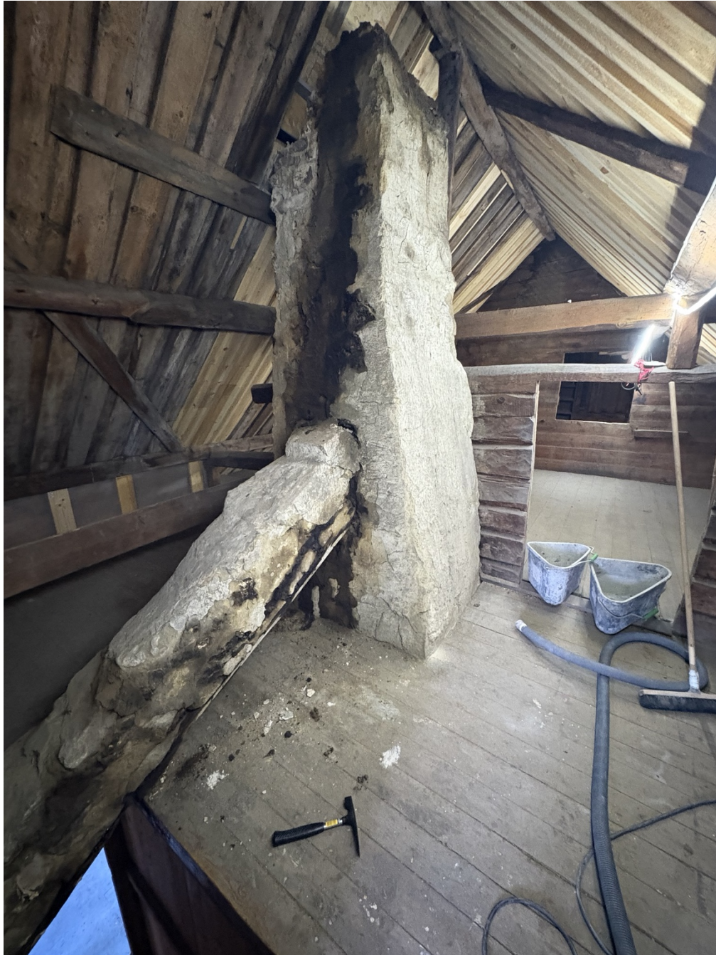
Oversiktsbilde av åpent ildsted før restaurering.
