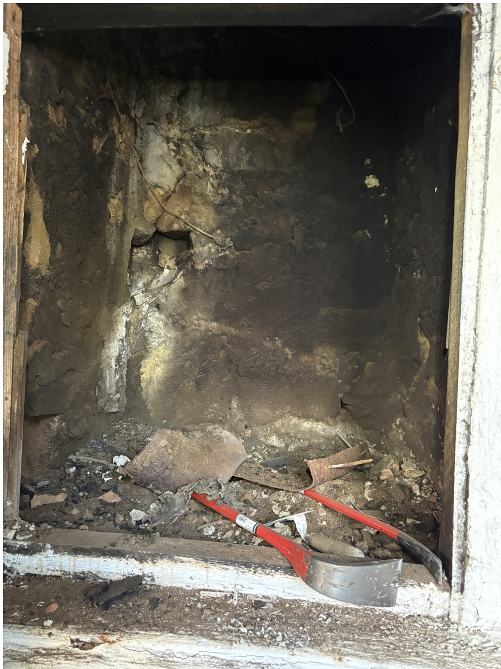
Bakside av konstruksjon før full rehabilitering.
