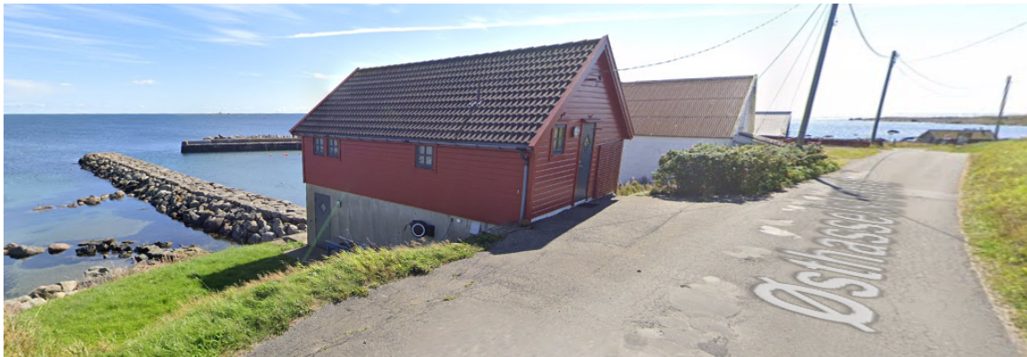
Sjøbod hvor det søkes om endring av romfunksjoner. Østhassel redningsstasjon i bakgrunnen.
