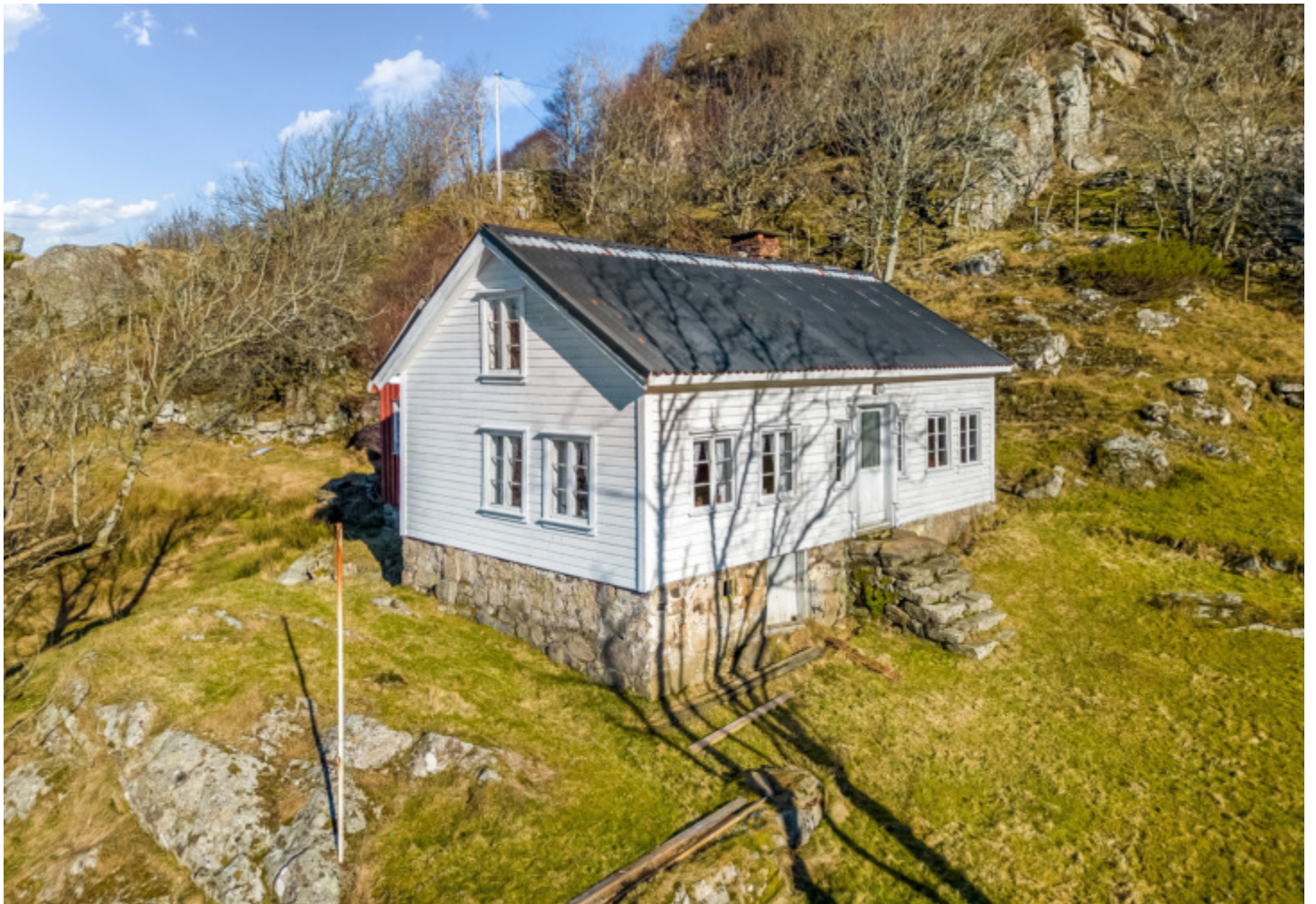
Eldre eiendom med renoveringsbehov med særs flott beliggenhet.
