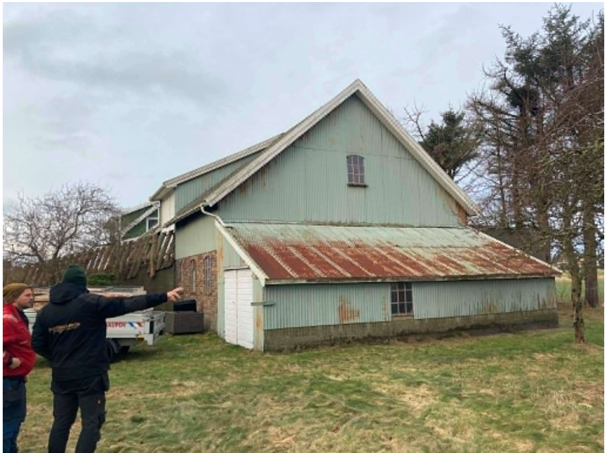
Bilde 3: fasade øst
