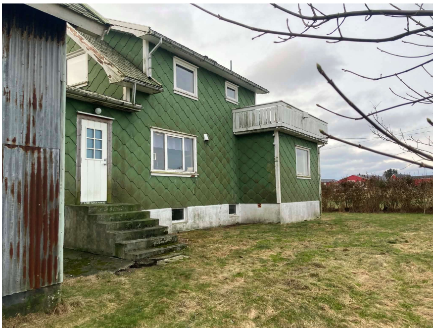
Bilde 5: fasade nord hvor tilbygg til bolig med takterrasse rives
