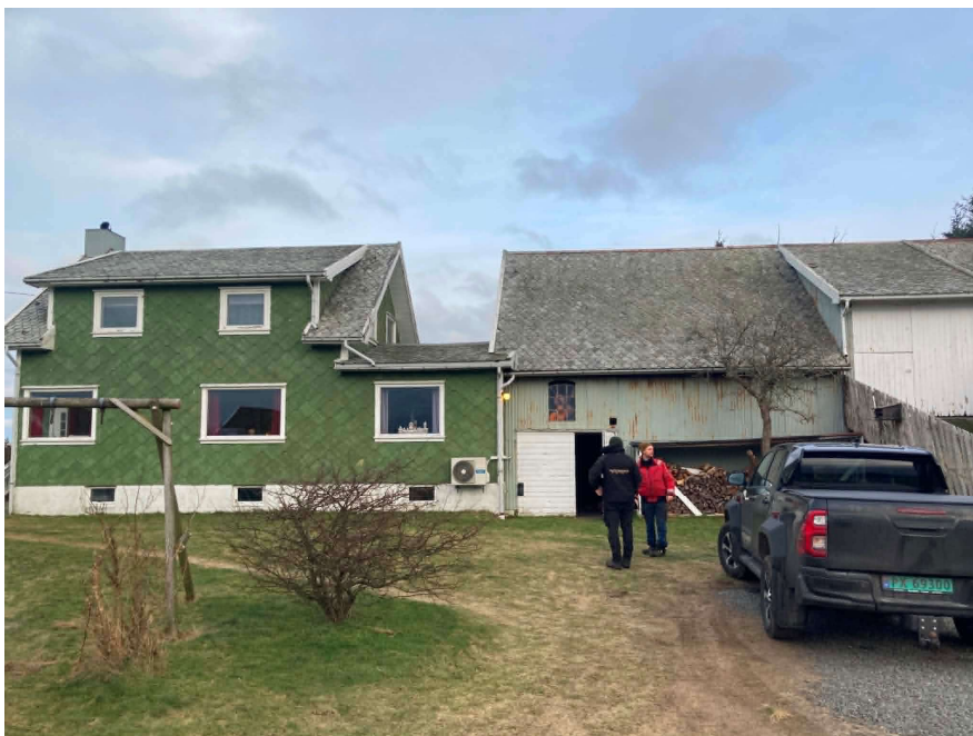
Bilde 1: fasade sør eks. bolig og løe som skal bevares.
