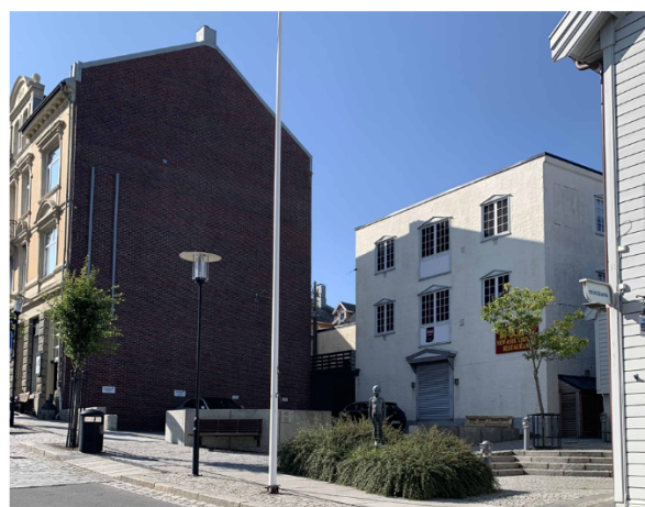
Dagens situasjon - sett fra Kirkegaten
