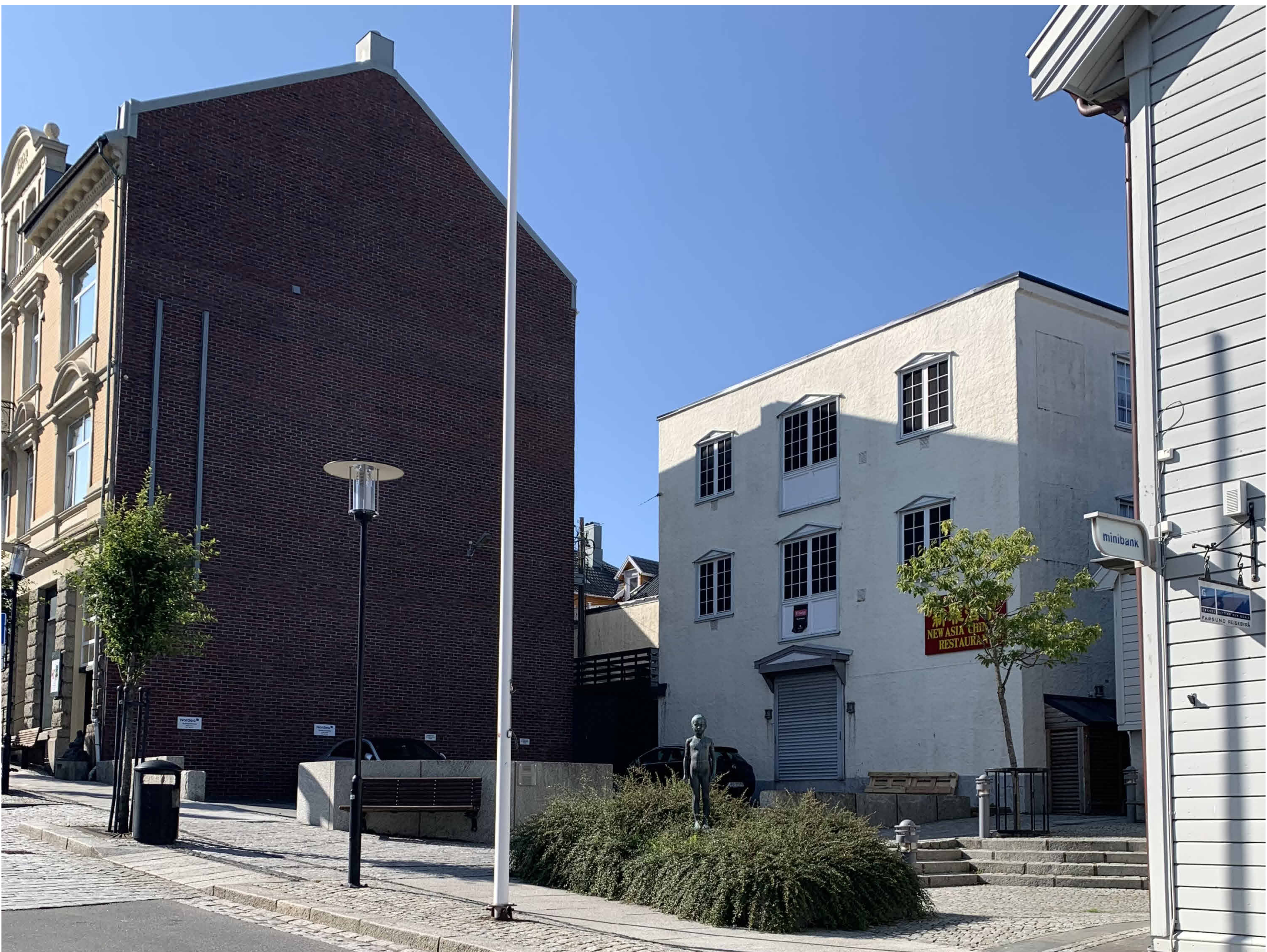
Dagens situasjon - sett fra Kirkegaten
