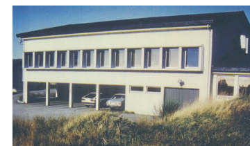
Stasjonsbygningen i 1980-årene. Foto: Telenor
