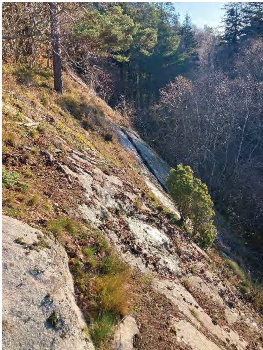
Figur 35 Større oppsprekking i fjell
