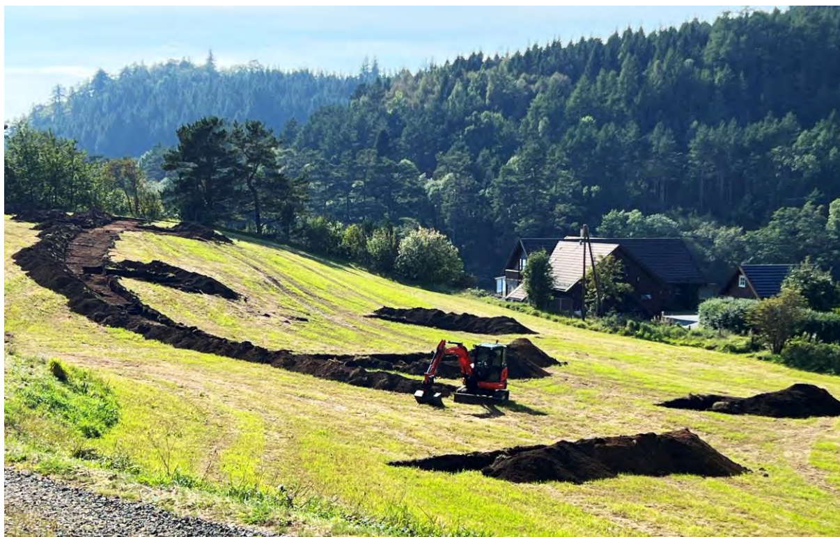
Figur 27. Oversikt over gbnr. 111/3 og de gravde sjaktene: sjakt 2-5.
