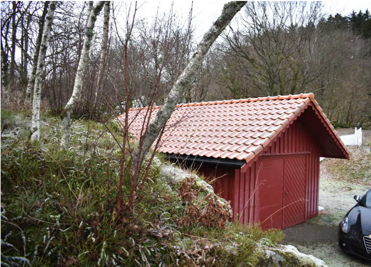
Eks anneks før ombygging - fra nordvest
