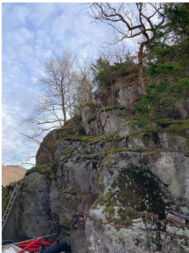
Bilde 1: foto som viser fjellformasjon med lite eller ingen løsmasse. Foto fra fasade sør.
