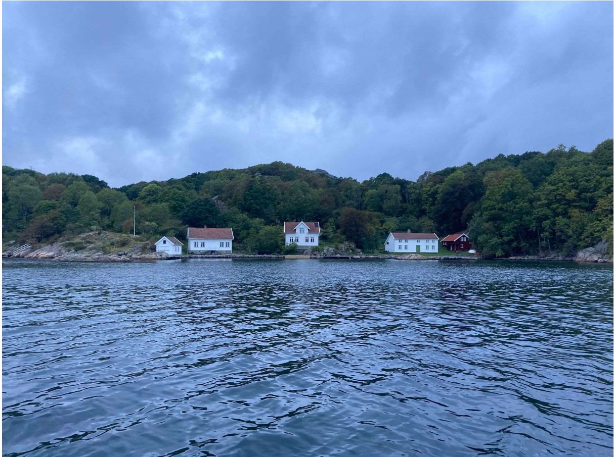
Bilde 4: Foto tatt fra sjøen 24.09.2024. Man klarer ikke å se grunnmuren herfra på grunn av tett vegetasjon.
