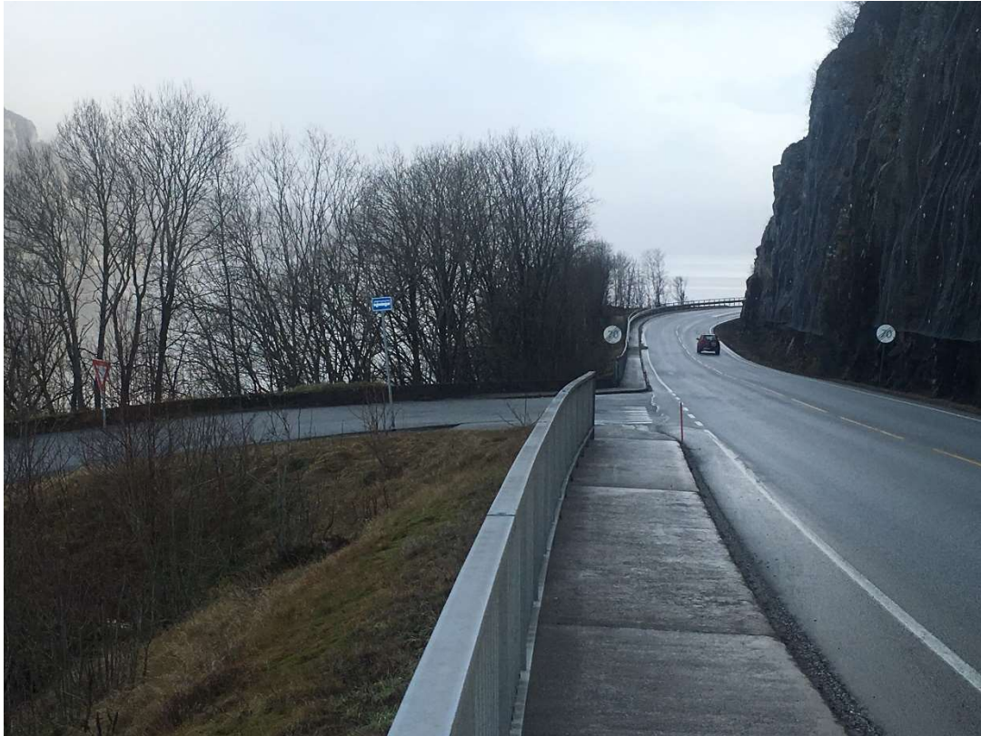
Dagens busstopp midt i avkjørsel.
