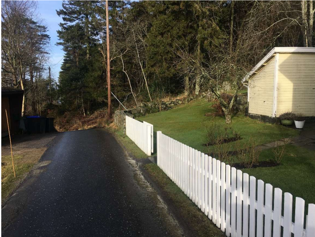
Ny atkomstveg starter ved stolpen (stakittgjerde er ved tomt 39)
