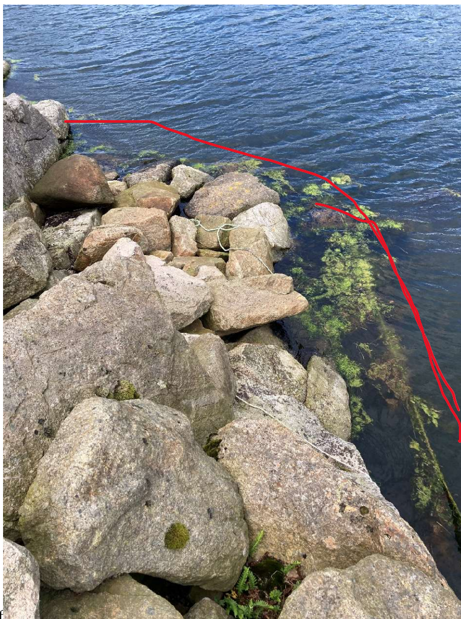
Bilde 2: Utfylling gjort av forrige generasjon som søkte om å etablere brygge. Dette blir ytterkant og avslutning av bryggen.
