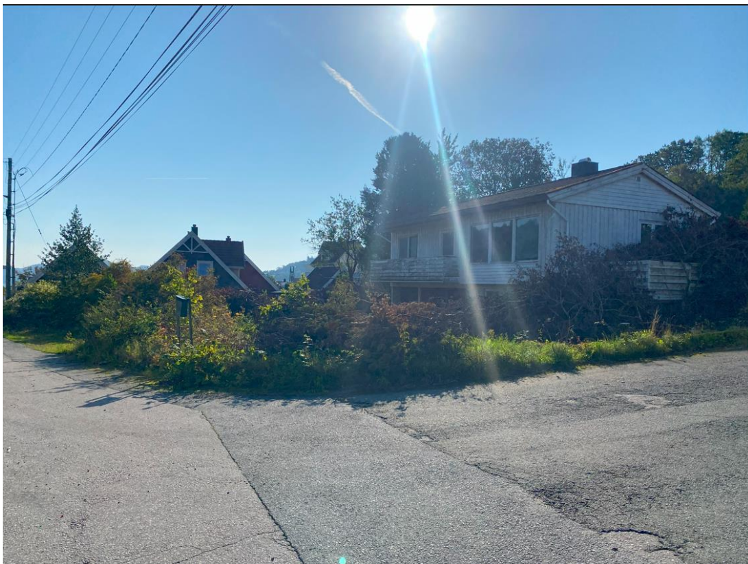
Figur 4 Bilde av husets fasade
